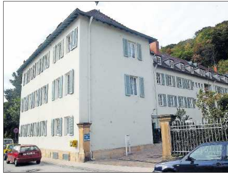
Der vordere Teil der früheren Fachklinik ist zurzeit noch nicht belegt. Die Stadt plant, dort längerfristig Familien unterzubringen. ARCHIVFOTO: LM
